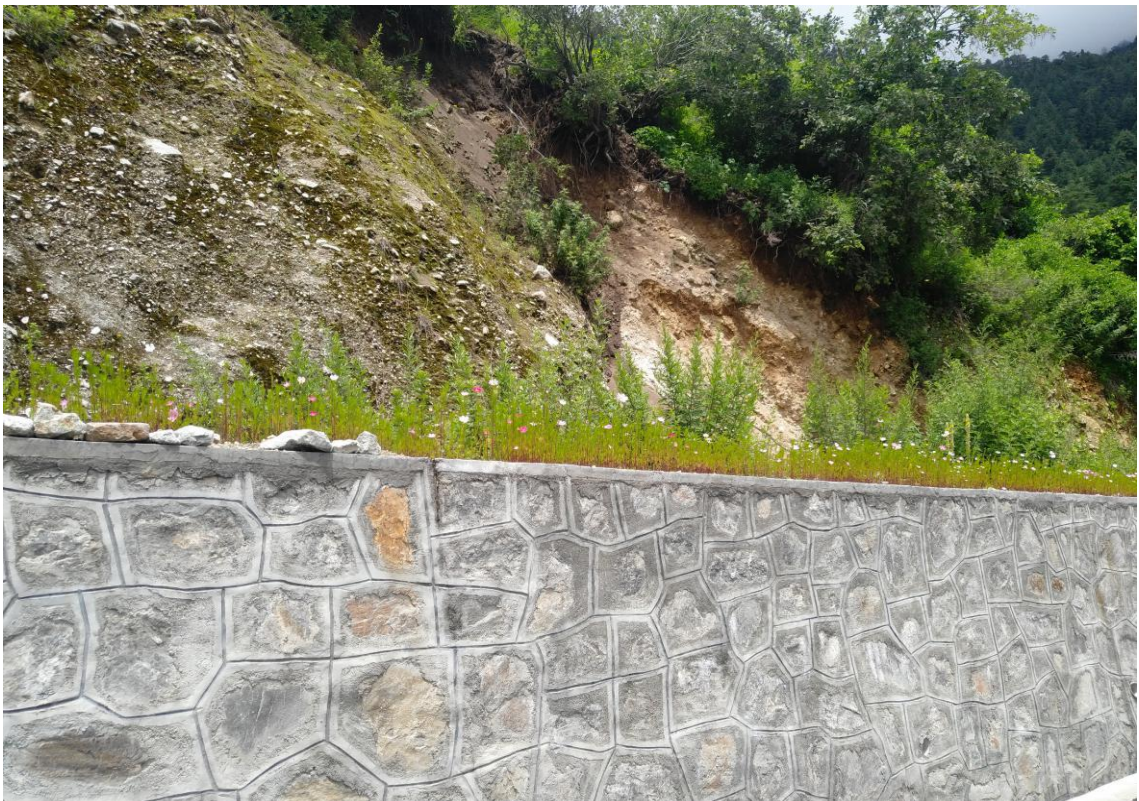
路基工程边坡种草
