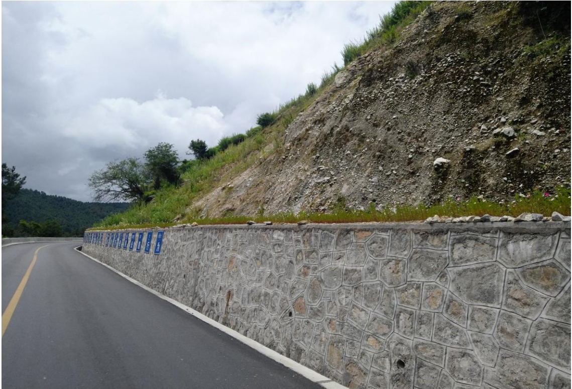
路基工程新修挡墙
