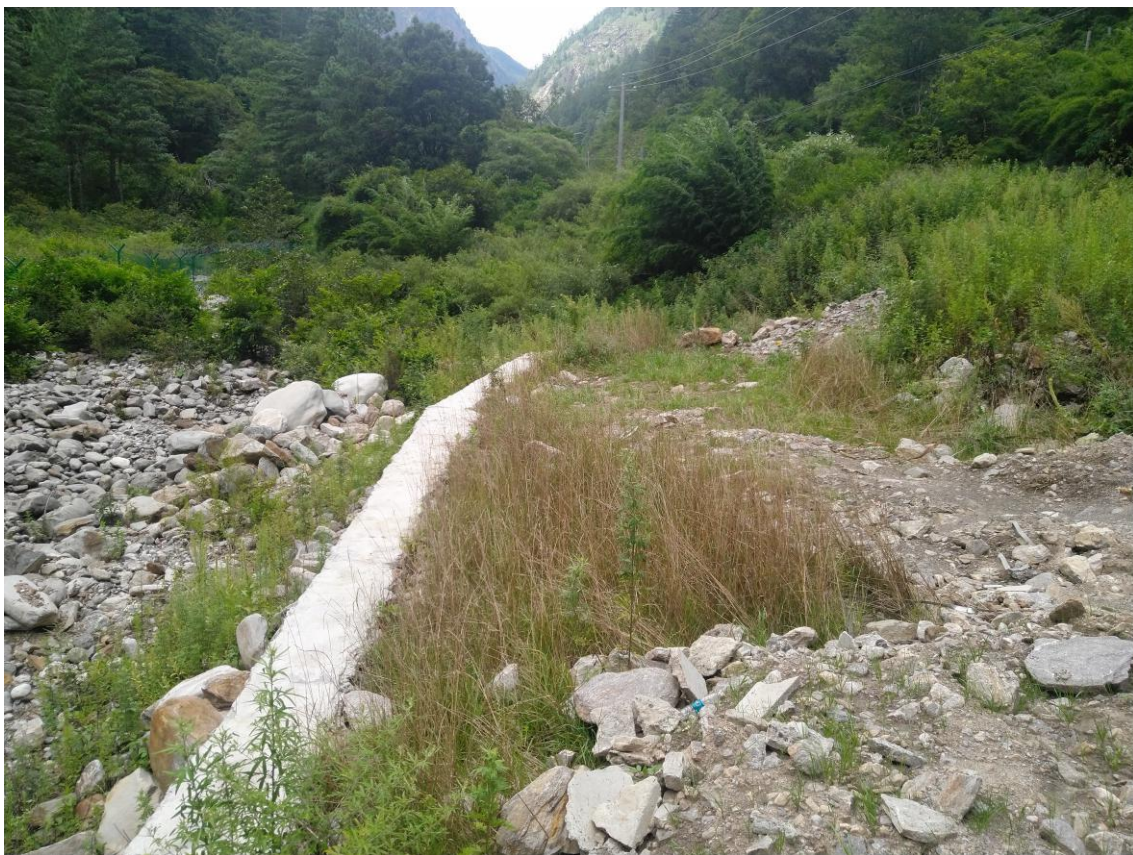
弃渣场区新修挡土墙
