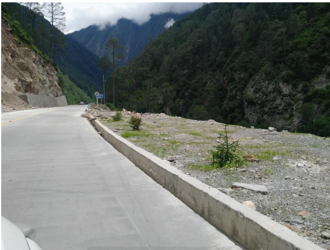
施工生产生活区迹地修复平整种树
