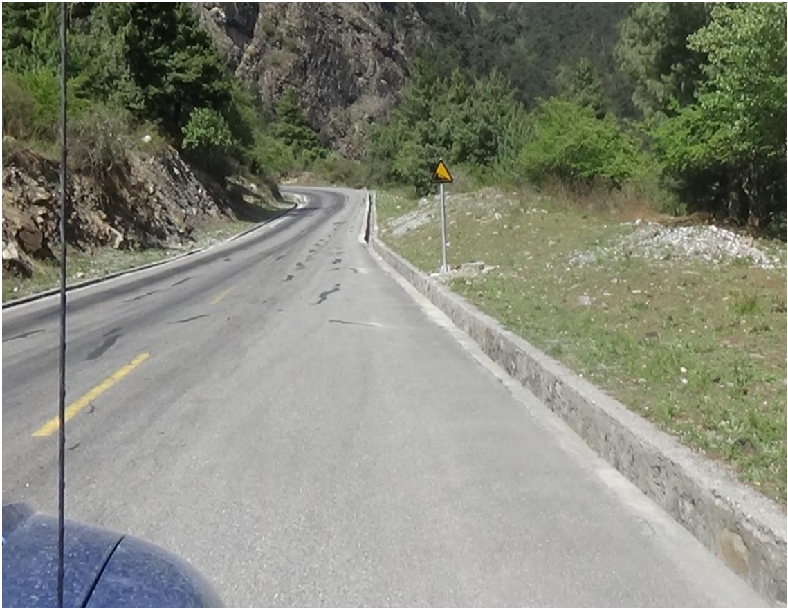
路基工程边沟
