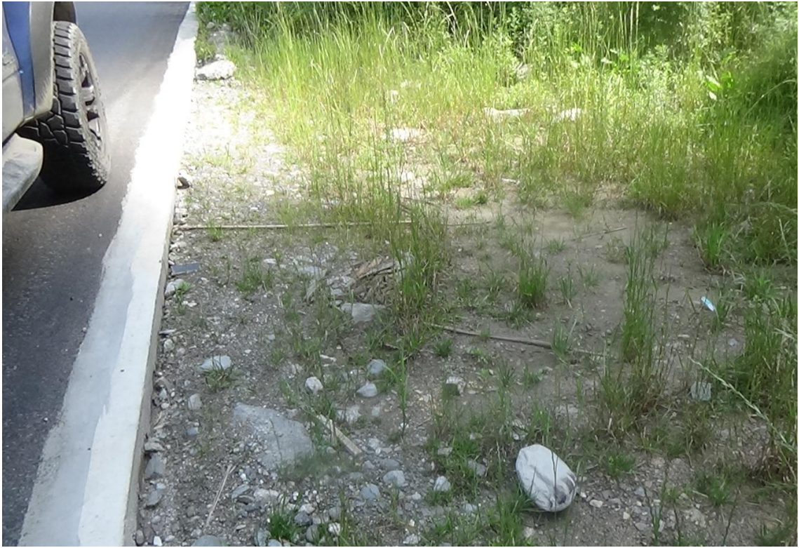
路基工程边坡种草
