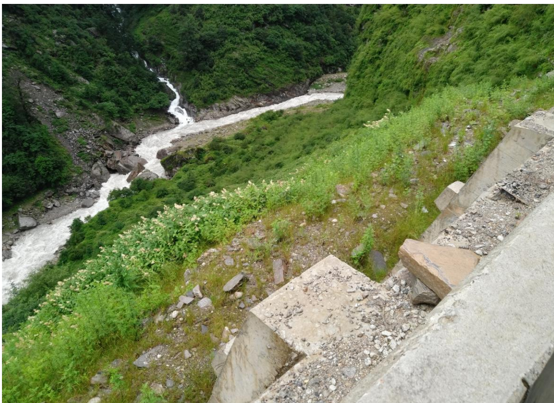
K88+900 处弃渣场区
